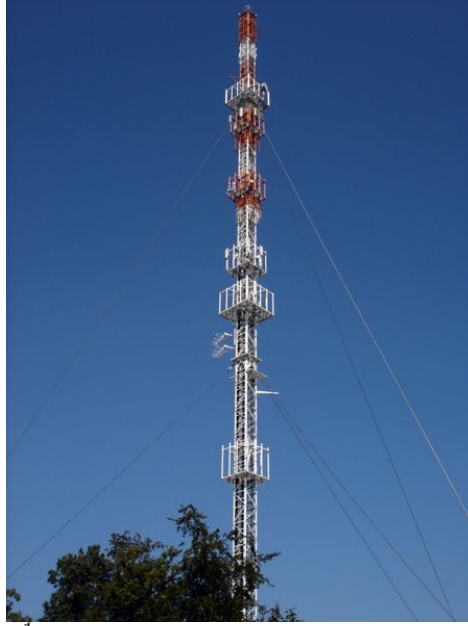
شكل 14: صارية مشدودة تحتوي على ستة شدّادات (مستويين يحتوي كلٌّ منها على 3 شدّادات).
