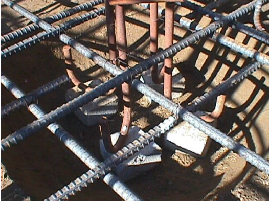
شكل 7: أ) طبقتين من قضبان التسليح المربوطة مع الروافع ب) قواعد التثبيت التي ستربط قاعدة البرج بالأساس لبيتوني
