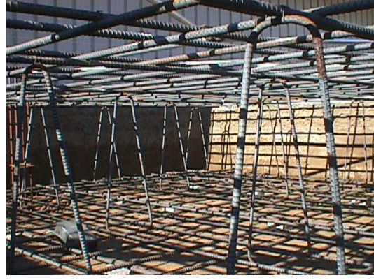
شكل 7: أ) طبقتين من قضبان التسليح المربوطة مع الروافع ب) قواعد التثبيت التي ستربط قاعدة البرج بالأساس لبيتوني
