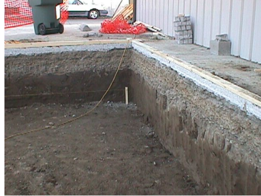
شكل 5: أ) الحفرة عقب الإنتهاء وتظهر جوانبها المستوية
