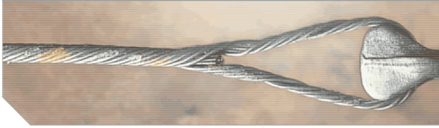
شكل 12: سلك شدّادٍ مثبتٍ باستخدام "Dead End".
